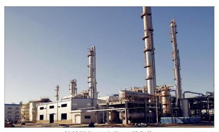
榆林煤化5万吨/年CO<sub>2</sub>捕集装置
